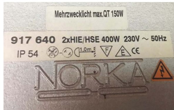
vanha asennus 400W metallihalidi tai natriumvalaisin
